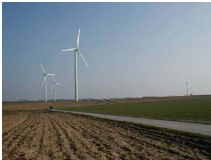
Figure 8 : Parc éolien de Gembloux-Sombreffe (source : APERe ® )
